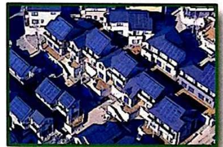
ソーラー発電システム
